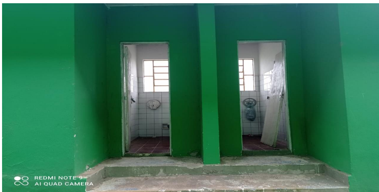
Sanitários da área externa que serão reformados para serem utilizados como lavanderia e depósito de materiais de limpeza.
