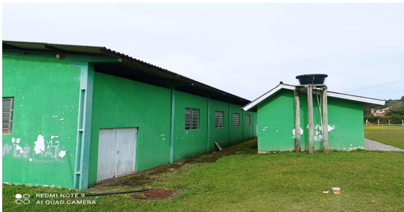
Fundos do Prédio - Lado esquerdo.
