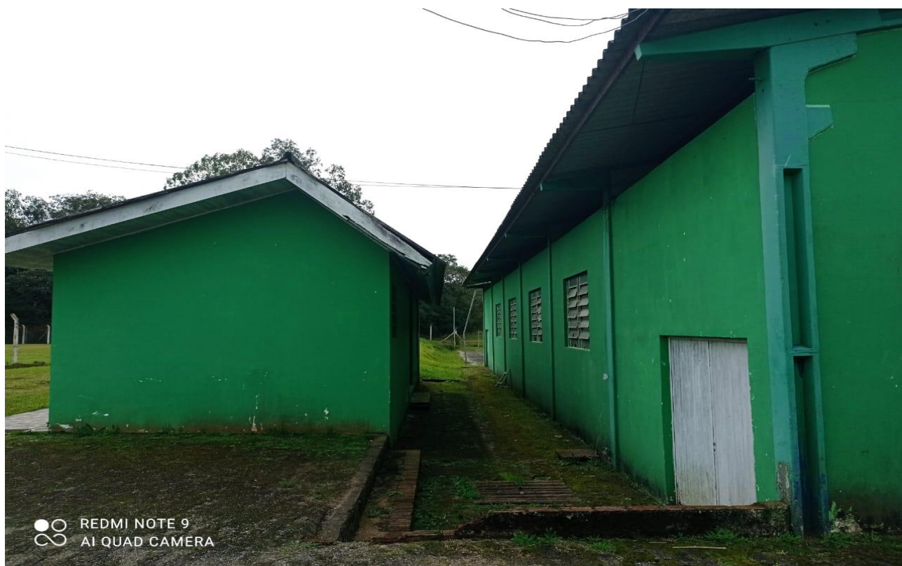
Fundos do Prédio – Lado direito.
